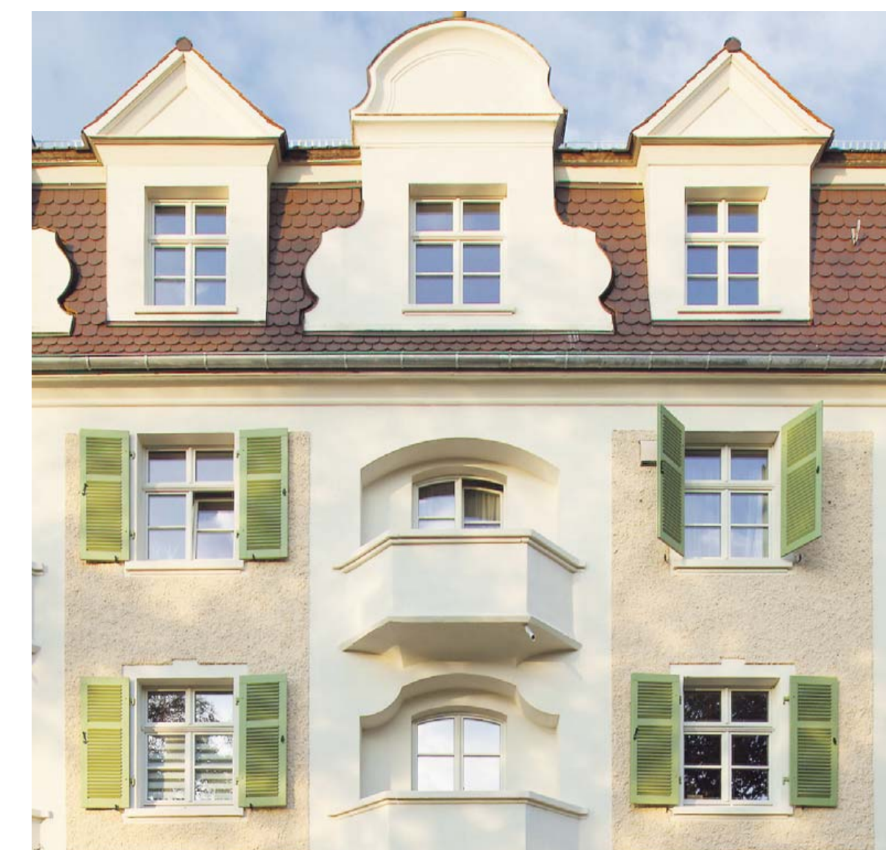
Sanierte Denkmalschutzwohnungen „Neue Hofgärten“ in Ludwigshafen: Fassade unverändert, Energiebilanz verbessert.
